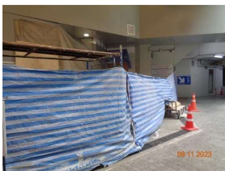
ภาพที่ 2.2-10 ผ้าใบกันฝุ่นภายในพื้นที่ก่อสร้าง
