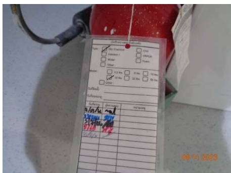
ภาพที่ 2.2-26 ตัวอย่างการตรวจสอบ ถังดับเพลิงเคมี
